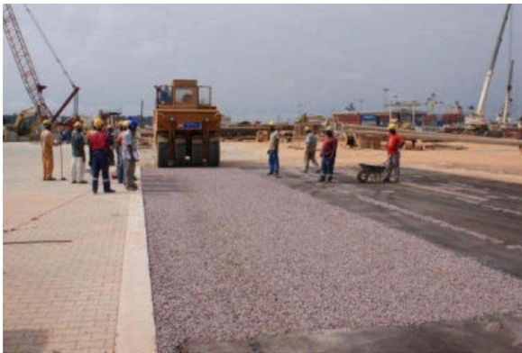
Заключительный слой наносится на слой Consolid
